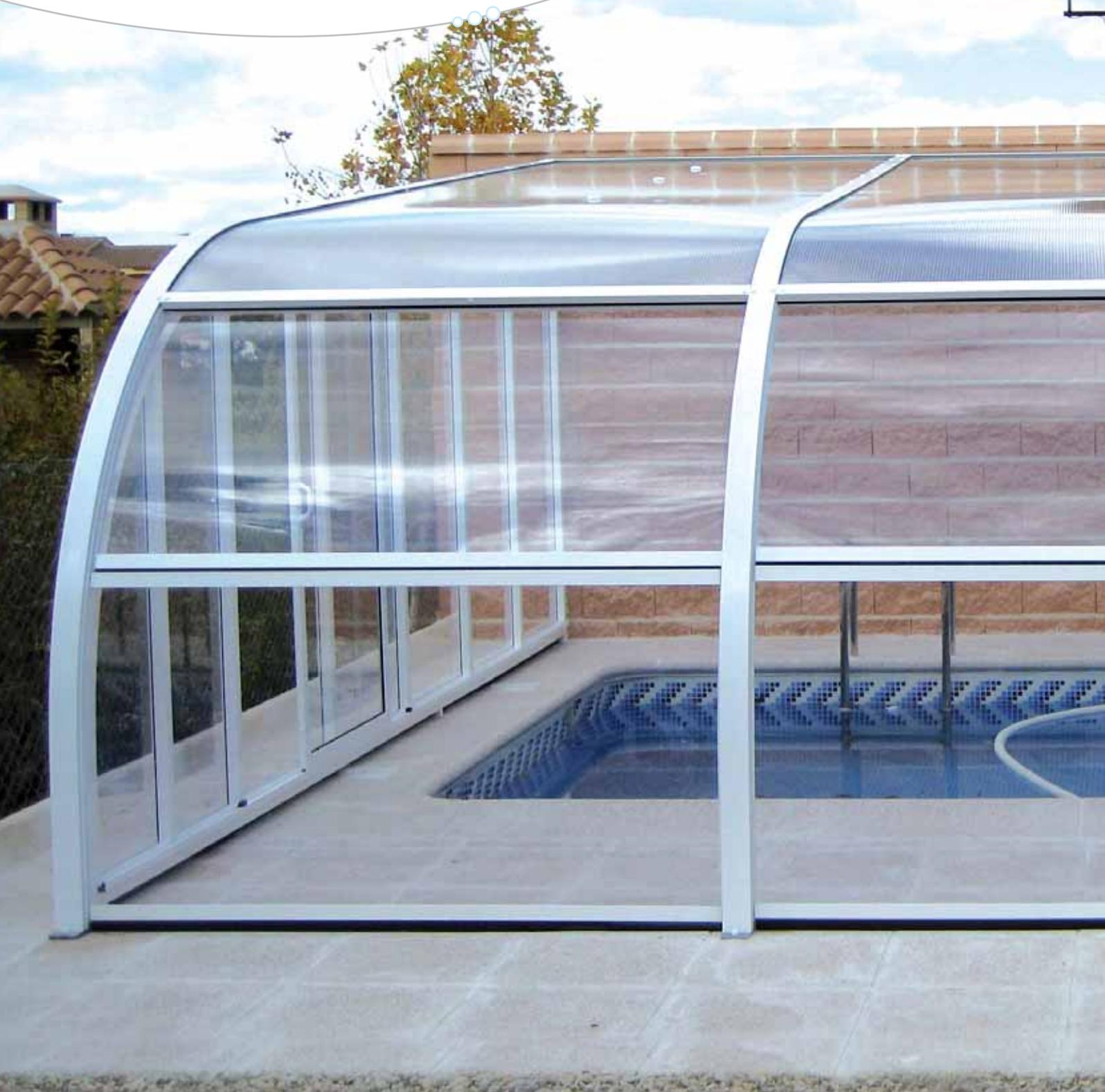
Se trata de una modalidad de la cubierta Lisboa, que se caracteriza por su acogedor diseño circular con ventilación perimetral total por medio de sus puertas de guillotina escamoteables bajo techo.
